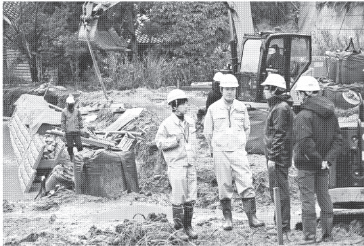
河川工事現場で工事責任者と作業状況を確認する金本さん（中央左）と小野さん（中央右から2番目） 2025年12月25日午後、石川県輪島市門前町和田
