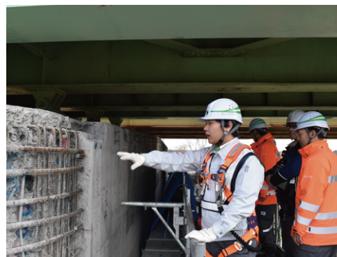
施工状況を確認する関谷さん
