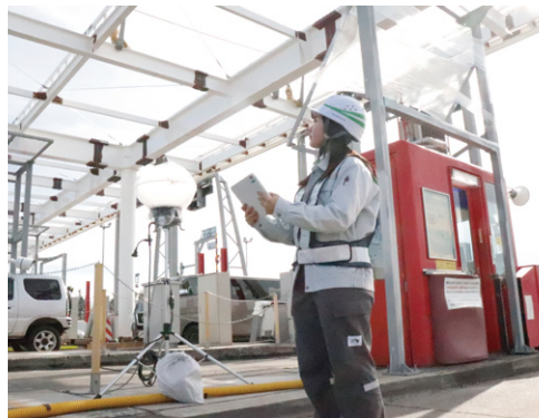
施工状況を確認する鹿島さん
