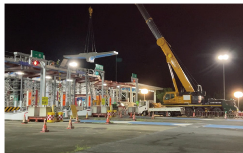
料金所ゲート夜間工事現場
