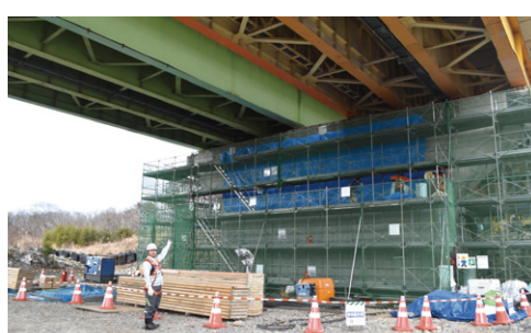
鬼怒川橋耐震補強工事現場
